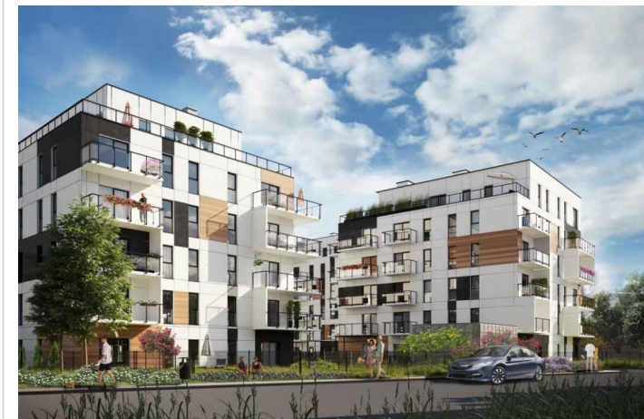
B1.07 BUDYNEK B1
