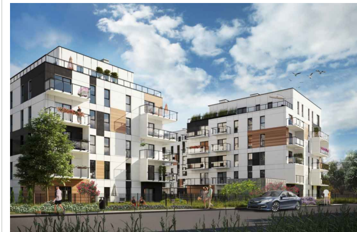
B1.12 BUDYNEK B1
