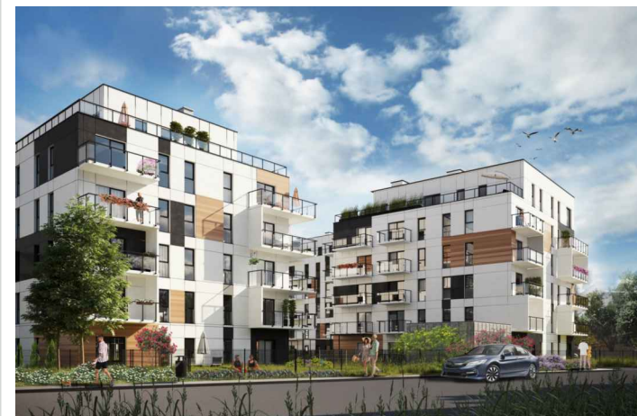
B2.07 BUDYNEK B1
