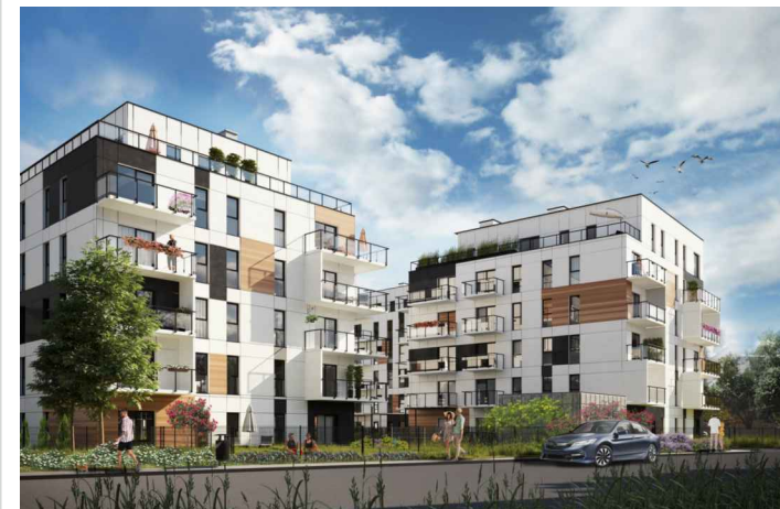
B3.13 BUDYNEK B1
